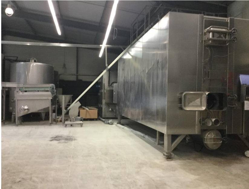
Epierreur et Germeoir (capacité 4 Tonnes)
